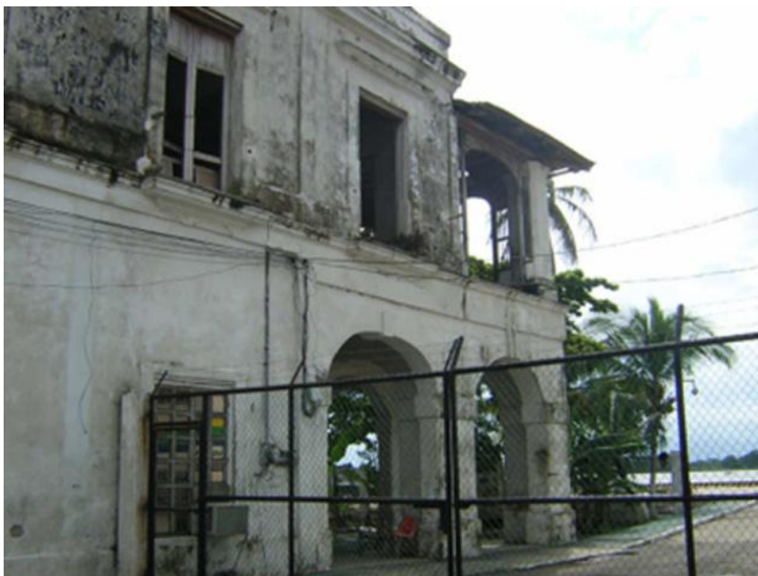
Foto 8.- Aduana marítima puerto de Frontera, Tabasco.
