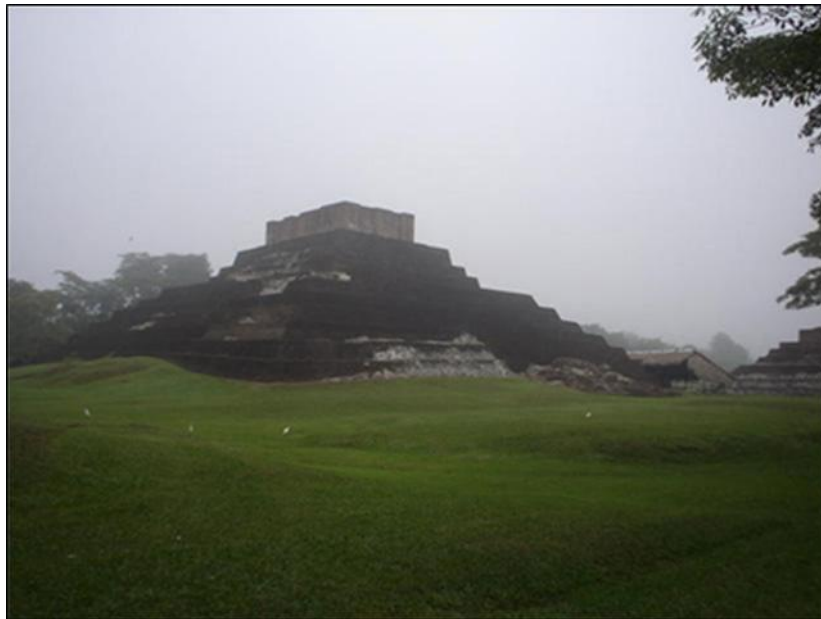
Foto 10.- Ladrillo utilizado como parte del sistema constructivo, Comalcalco, Tabasco.
