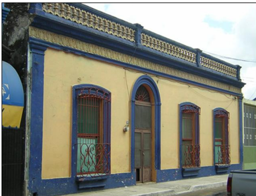
Foto 7.- Edificio del S. XIX en el puerto de Frontera, Tabasco.
